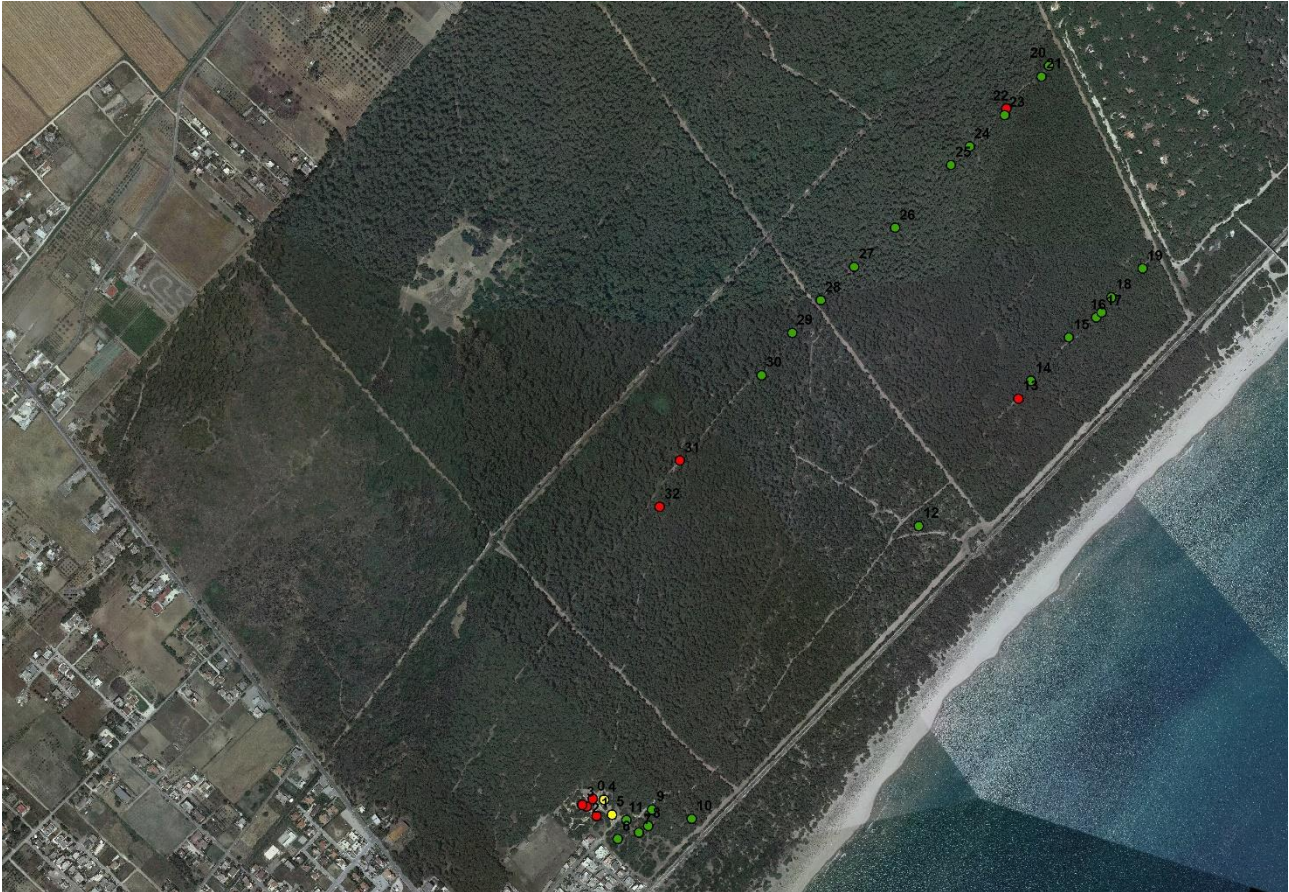
Figura 18. Posizione e stato di conservazione delle attrezzature censite (in rosso le situazioni critiche, in verde condizioni intermedie, in giallo le condizioni migliori).
